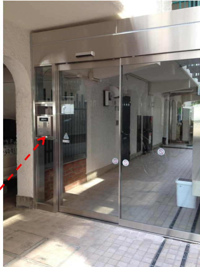
自動ドアへの組み込み施工例
